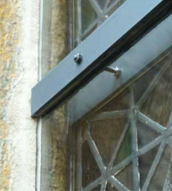
Die Bleiverglasung wurde um etwa 5 cm nach innen versetzt eingebaut. Die Schutzverglasung sitzt außen davor
